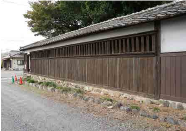
南棟 南面全景
