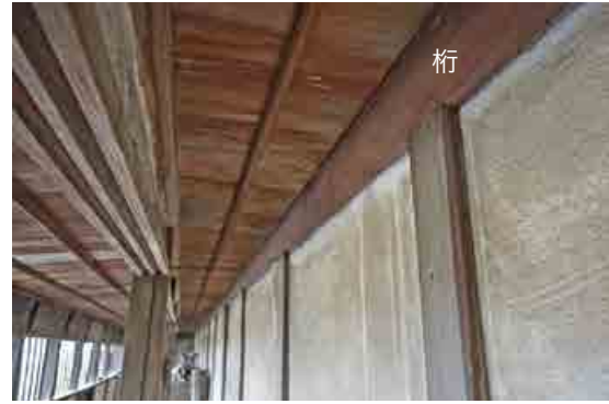
陳列棚の奥に見える杉磨き丸太長尺材の桁
