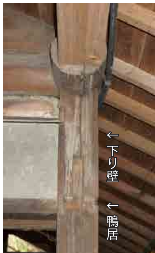
南面 鴨居及び下り壁 柱 A の痕跡
