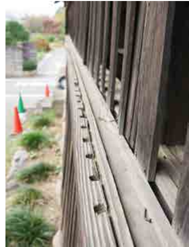
鉄格子敷居 雨戸敷居 窓外側には使用されなくなった敷居が残存。戸袋はない
