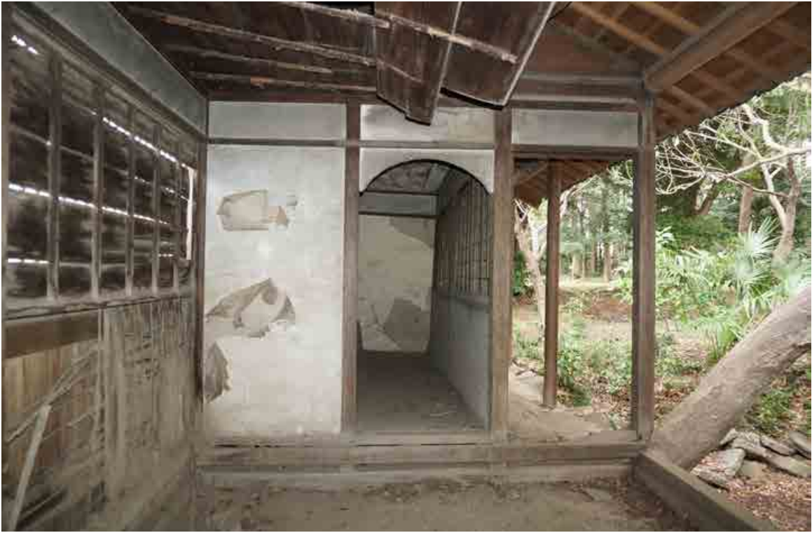
西棟入口を見る。この右手が陳列場への入口、当初は開き戸 画面右には障子戸が建て込まれ、池に張り出す小さな縁があった
