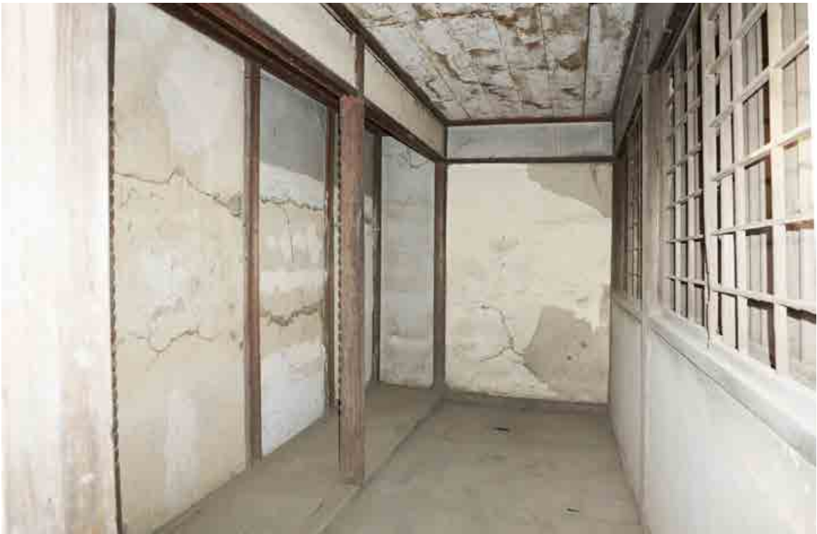
西棟入口から奥を見る。西壁全長2間が展示棚。床は畳敷き、天井は白漆喰塗 窓には障子戸、外側に格子が取りつく
