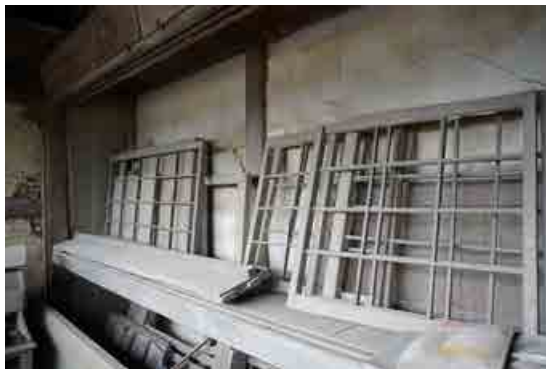
棚には窓の障子戸が多数残されていた
