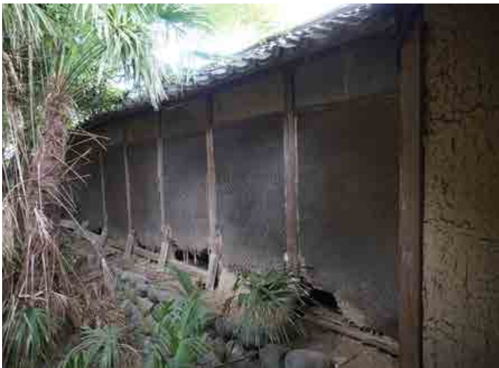
南棟北面外壁 全長に竹網代が張られている
